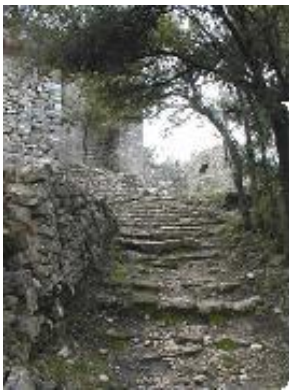
[7] Les escaliers de la chapelle.
