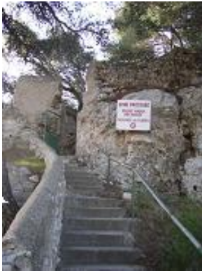
[4] Les escaliers à droite vers la chapelle.
