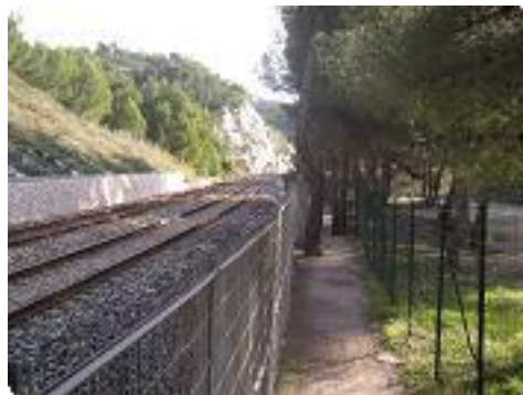
[11] Longer la voie ferrée.
