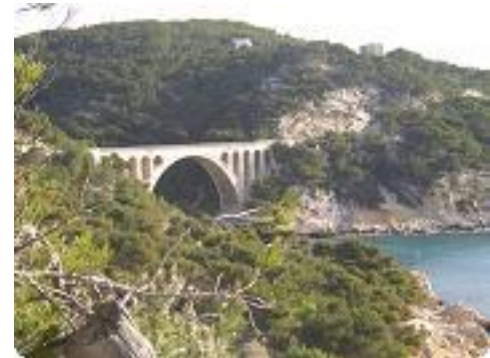
[9] L'édifice des chemins de fer.
