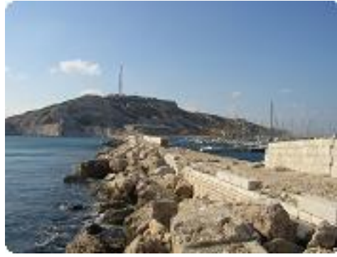
[14] La digue de protection du port.
