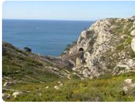
[17] Approche de la voie ferrée.
