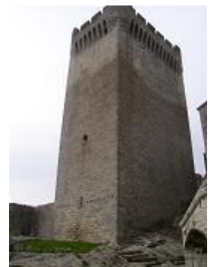
[12] La tour Pons de l'Orme.
